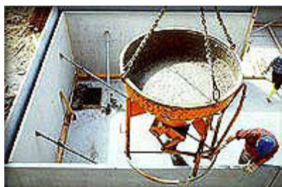
Weißer Wanne errichtet mit Dreifachwänden
